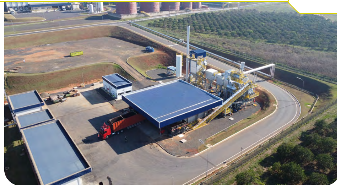
Planta de geração de energia térmica por meio da biomassa.
